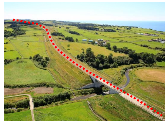
<代替道路の整備>
