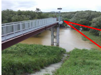
樋門 (洪水流の逆流を防ぐ施設)
