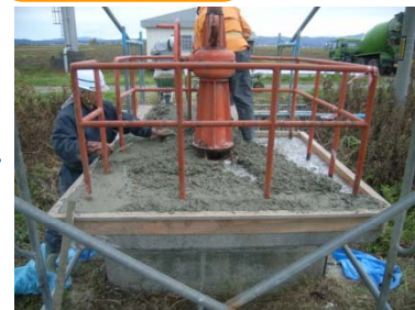
出水に備え、施設補修の実施
