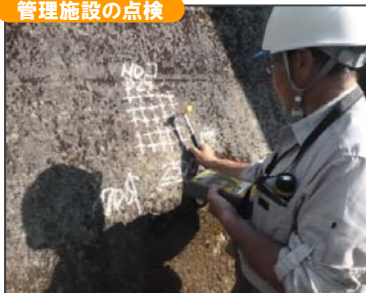
ダムや樋門等の点検
