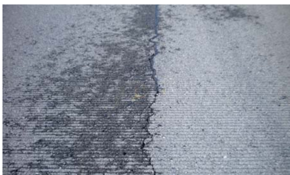
老朽化した舗装
