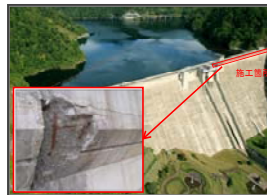
ダム天端高欄 コンクリート剥離
