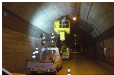
トンネル修繕
