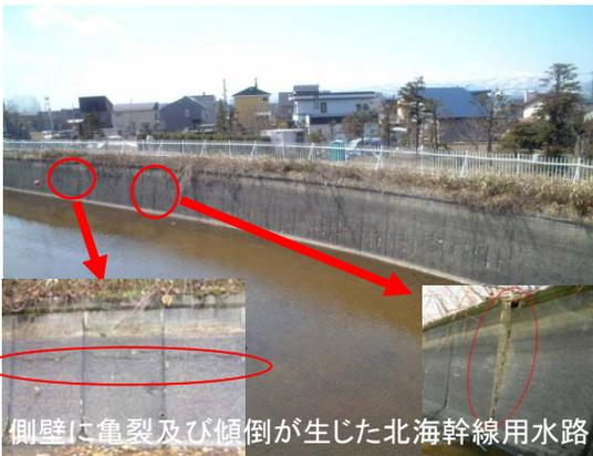
側壁に亀裂及び傾倒が生じた北海幹線用水路
