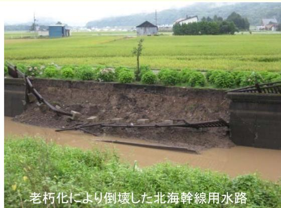
老朽化により倒壊した北海幹線用水路
