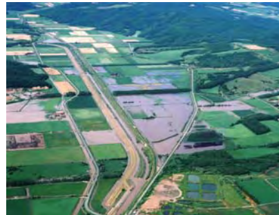
H15年8月洪水 (浸水状況)
