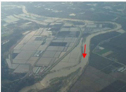
H18年5月洪水 (浸水状況)
