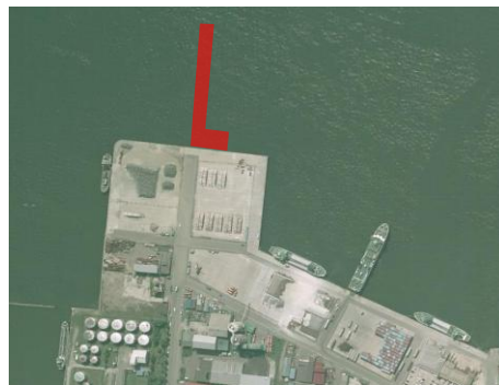
耐震強化岸壁整備箇所(函館港)
