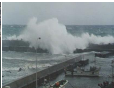
防波堤からの越波状況 (江良漁港)
