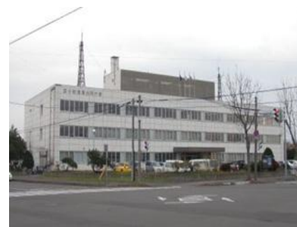
苫小牧港湾合同庁舎 長寿命化改修
