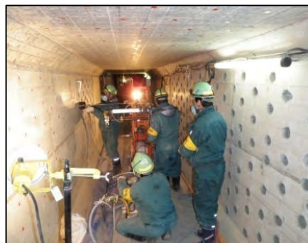
耐震補強対策施工状況
