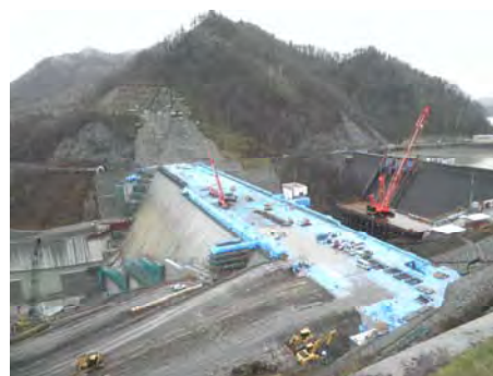
夕張シューパロダム（本体工事）
