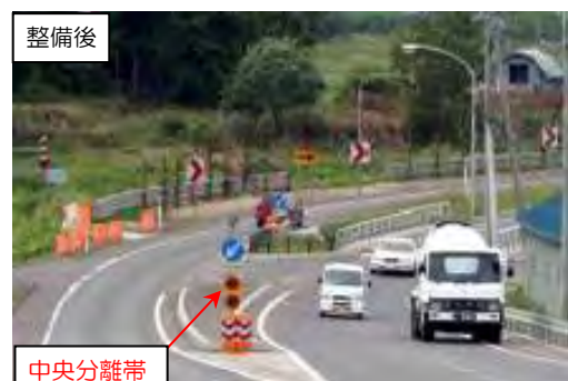
正面衝突事故対策の例（中央分離帯設置）
