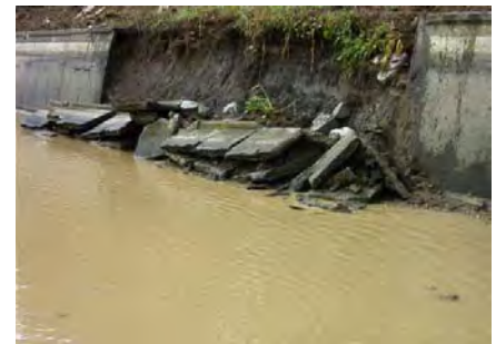
老朽化により用水路が倒壊 【国営かんがい排水事業】
