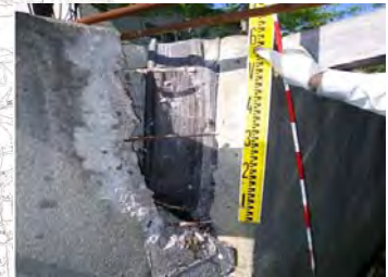
機能低下状況 (排水機場側壁)
