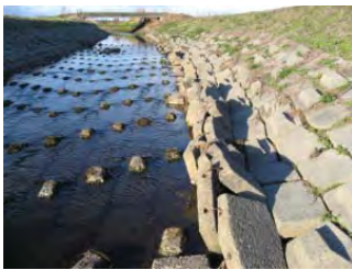
機能低下状況 (排水路護岸ブロック)
