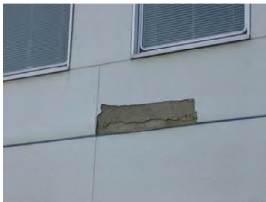
危険箇所の解消（落下した外壁パネル）
