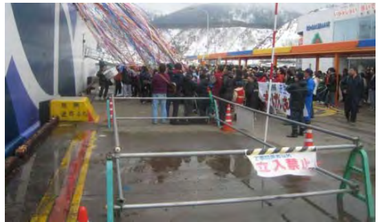
岸壁の老朽化による立入禁止措置 (鷺泊港〔利尻島〕)
