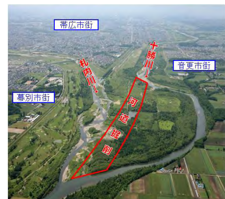
十勝川相生中島地区改修
