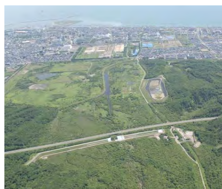
苫小牧川遊砂地(建設中)
