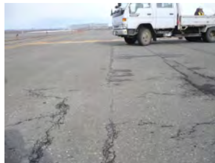
既設誘導路舗装の劣化状況
