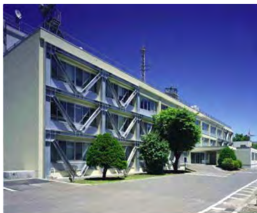
耐震改修の事例
