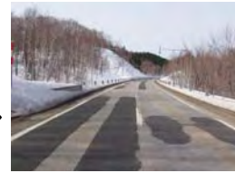
舗装の轍ぼれ箇所の局所的な補修
