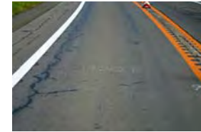
ひび割れ箇所のシール剤注入による延命措置
