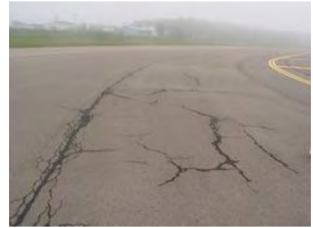
既設誘導路舗装の劣化状況
