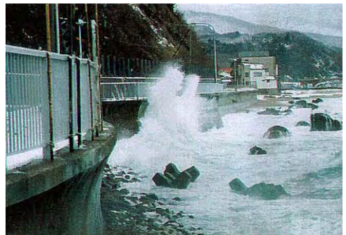
奥尻港海岸（奥尻地区）荒天時
