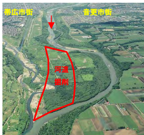
十勝川相生中島地区改修
