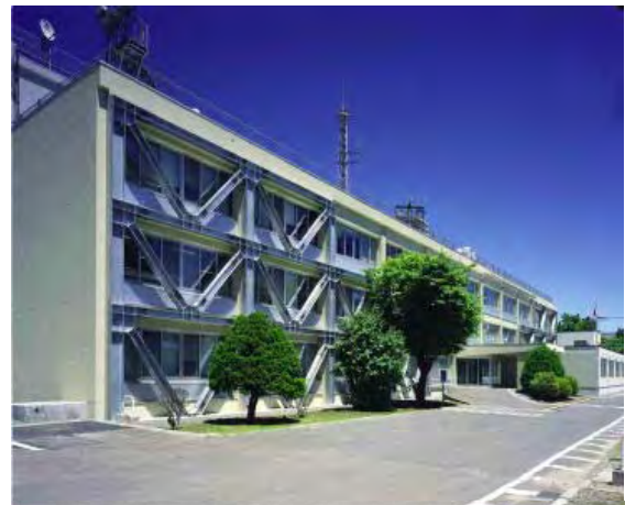
耐震改修の事例
