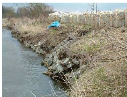
更新整備が必要な排水路 (国営かんがい排水事業)
