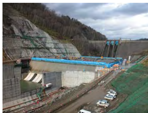
夕張シューパロダム建設状況
