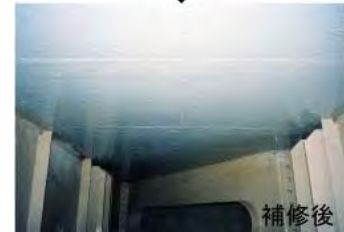
既存橋梁の長寿命化
