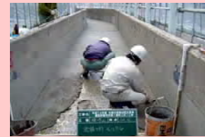
ポリマーセメントモルタルによる補修
