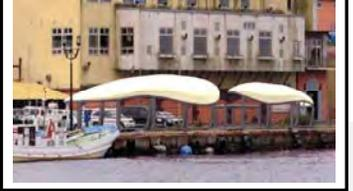
津波来襲により船舶や車両等が漂流物となることから、寄せ波時には衝突被害を防ぎ、また引き波時には漂流物が海側へ流出するのを防ぐ津波漂流物対策施設の整備検討を推進していく
