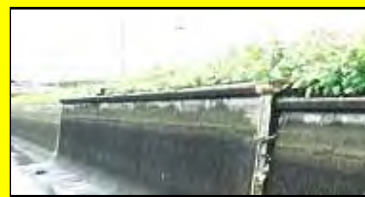
用水路の老朽化等により整備が必要
