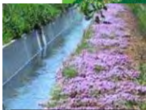
空知中央地区における農業用水路法面の景観植栽
