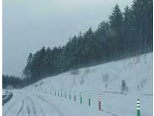
既存林を活かした防雪林の例 (一般国道40号 豊富バイパス)
