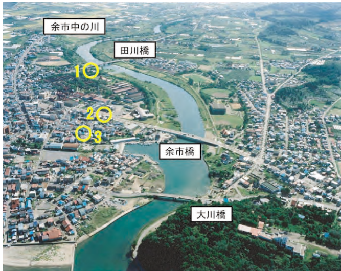
余市町市街地斜め写真
