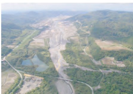
ダム現況（建設中）
