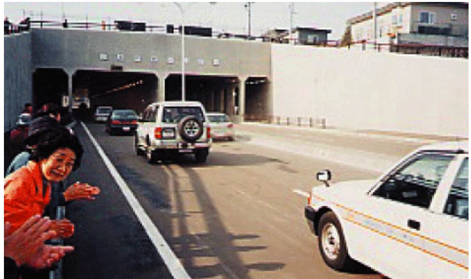
供用開始したトンネル部
