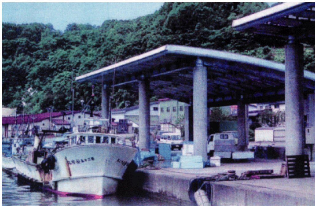
古平漁港 防風防雪施設
