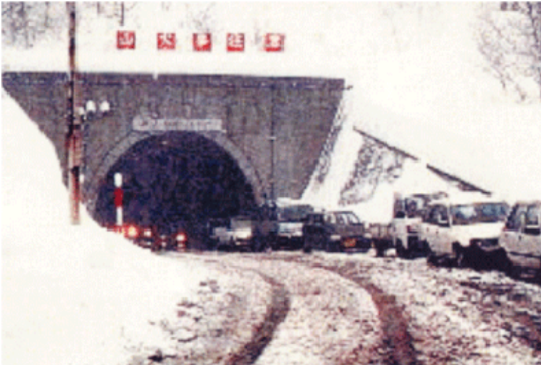
縦断勾配が急なため、大型車のスリップにより冬期間頻発する渋滞状態
