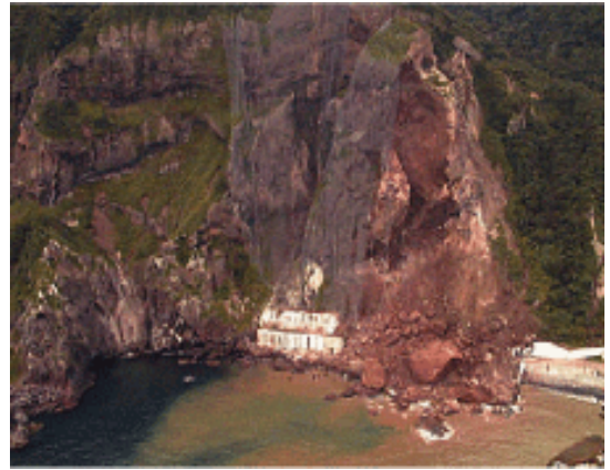
第二白糸トンネル崩落災害 (平成9年8月25日 撮影)
