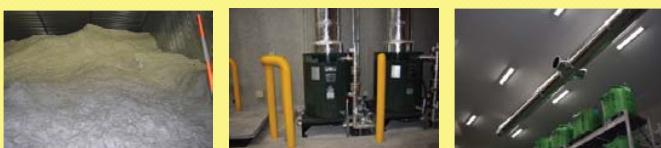
貯蔵庫内の大量の雪（左）が溶けた冷水を熱交換機（中）により倉庫内の空気と熱交換し、倉庫上部のダクト（右）を通して冷房する。
