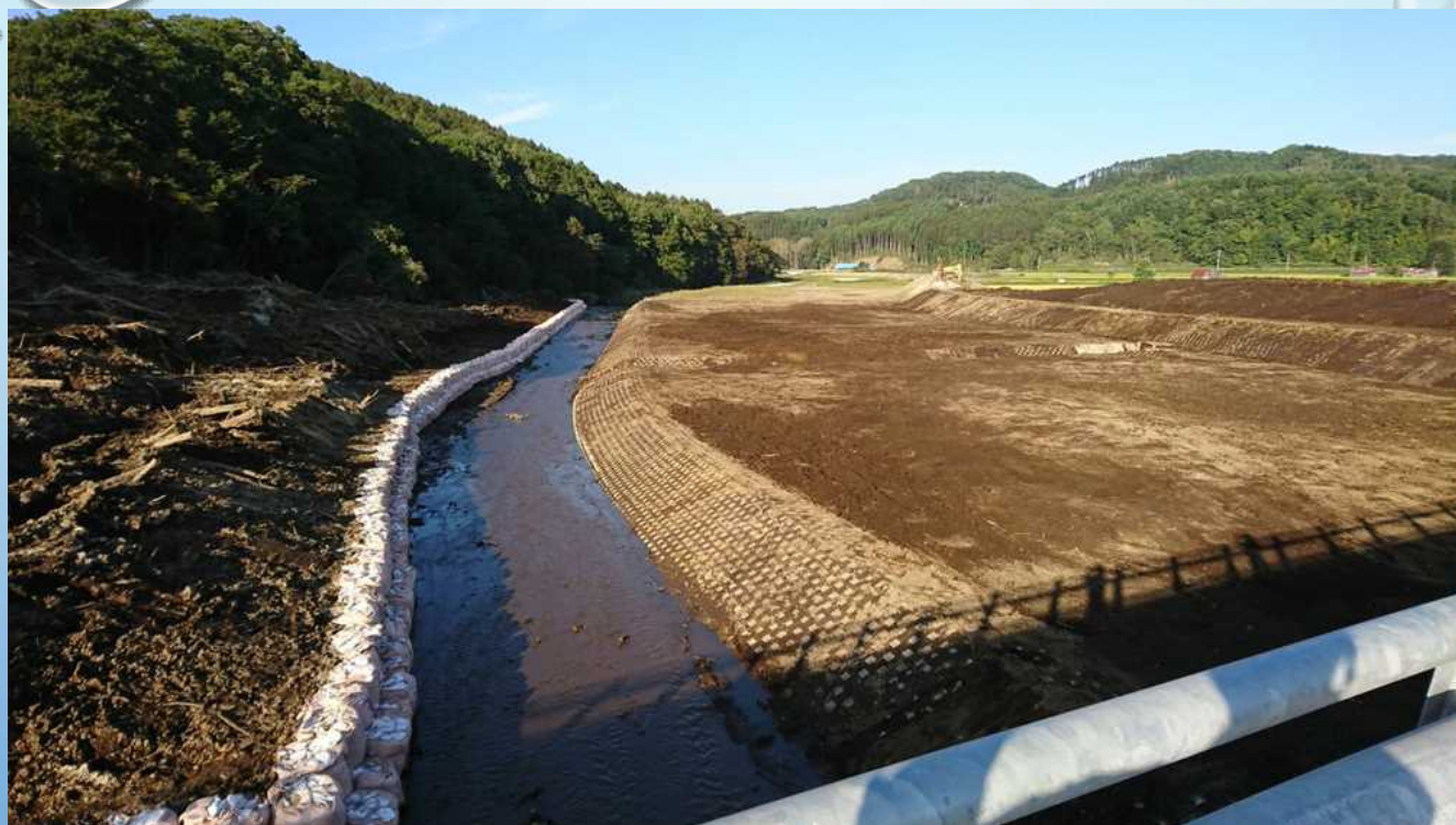
幌内橋から上流を望む（ 9月15日撮影 ）
