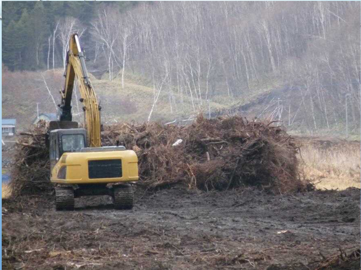
◇北海道胆振総合振興局室蘭建設管理部苫小牧出張所事業実施箇所 搬出作業
