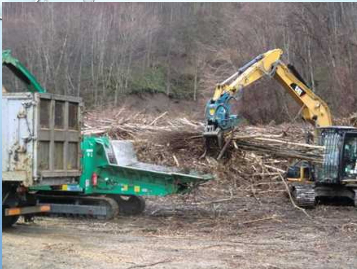
◇北海道開発局事業実施箇所 搬出作業
