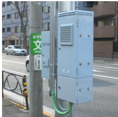
信号機用非常電源
