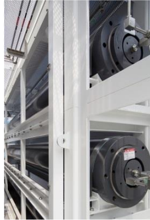
日本初の商用水素ステーション(尼崎)に採用された 鋼製蓄圧器 (写真提供：岩谷産業(株)殿)
