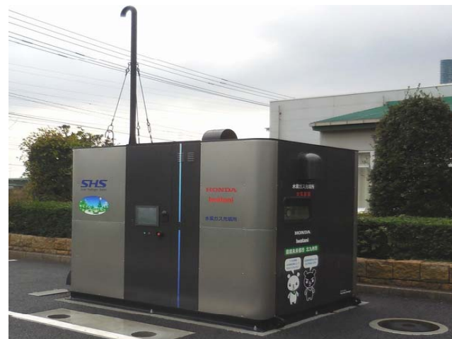
地産地消再エネ水素ステーション (ホンダ・SHS)
