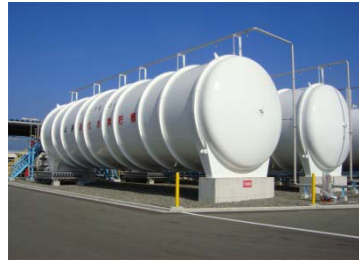
液化水素貯槽
