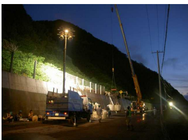
H22.7 一般国道229号（島牧村） 土砂崩落箇所の復旧作業支援
