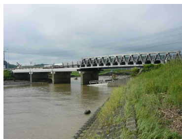
H15.8 一般国道235号（門別町） 慶能舞橋架設状況
