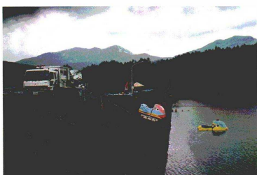
H7.5 和歌ダム(新十津川町) 堤体調査に伴う緊急排水 [自治体支援]
