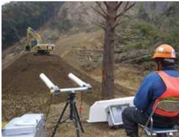
遠隔作業状況
