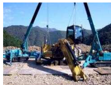
組立作業状況
