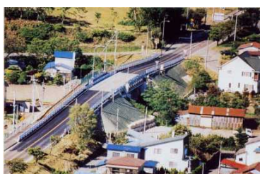
H12.5 一般国道230号（虻田町） 入江跨線橋架設状況
