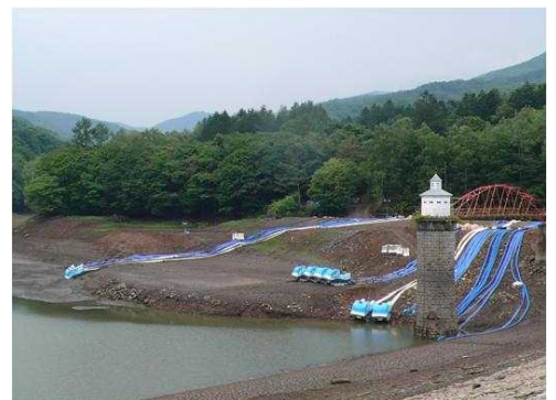
H23.8 奥沢ダム(小樽市) 堤体陥没に伴う排水支援
