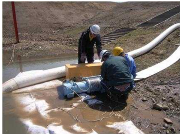
排水ポンプ設置作業
