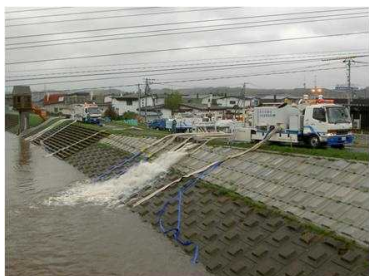
H18.10 低気圧による大雨 内水排除作業支援（美幌町） 〔自治体支援〕
