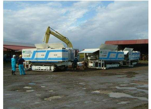
H18.10 低気圧による大雨(美幌町) 土のう造成作業
