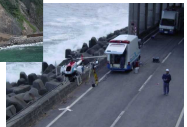
H16.1 一般国道336号（えりも町） 斜面崩落
