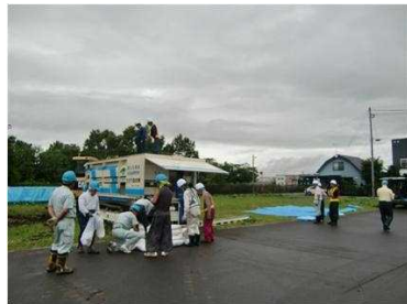
H22.8 低気圧による大雨 (旭川市)土のう造成作業 [自治体支援]
