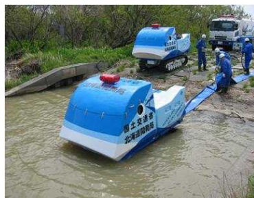
搬入作業状況
