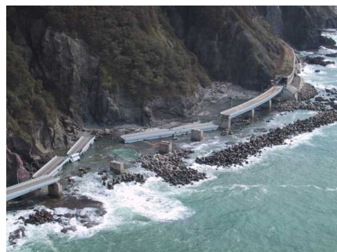
H16.9 台風18号 一般国道229号（神恵内村）大森大橋落橋の様子
