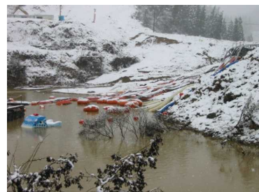
H16.11 新潟県中越地震 (新潟県山古志村) 天然ダムの緊急排水作業
