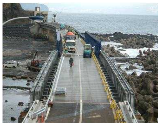
H16.9 一般国道229号（神恵内村） 大森大橋架設状況
