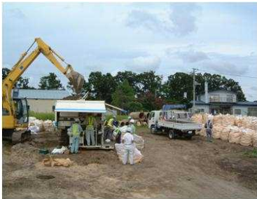
H18.8 一般国道235号 (日高自動車道)土のう造成作業
