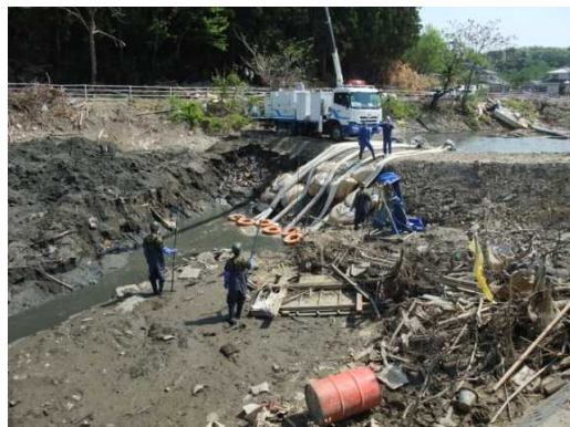
H23.3 東日本大震災（宮城県東松島市） 自衛隊による捜索活動の支援のため 浸水箇所の緊急排水作業を実施 〔自治体支援〕
