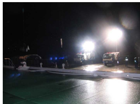
H23.3 東日本大震災（福島県相馬市） 広域防災フロント派遣に伴う作業支援
