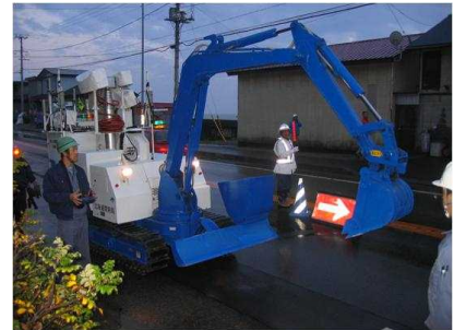
H15.10 一般国道236号（浦河町） 落石箇所における調査作業
