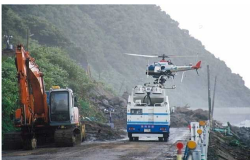
H14.8 一般国道229号（島牧村） 土砂流出
