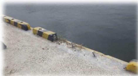
車止めの欠損や防舷材の損傷については、安全確保のため補修が必要です
