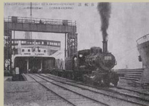
鉄道連絡棧橋貨車航送可動橋 〔函館商工名録〕昭和11年版
