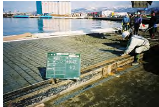
コンクリート舗装（鉄網設置）
