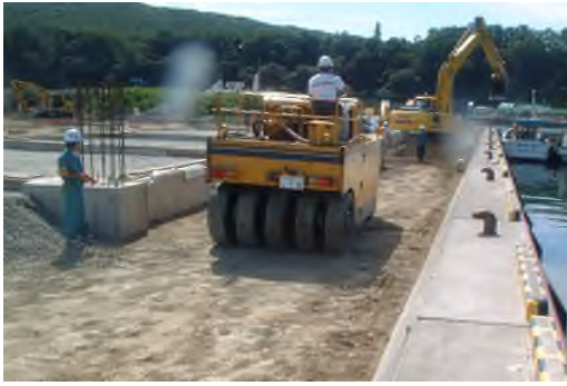
路床工（転圧状況）
