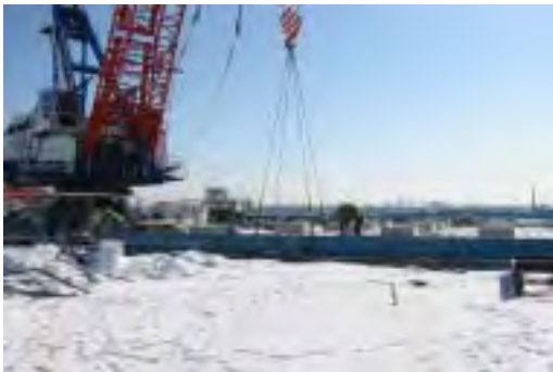
ブロック積込（蓋ブロック）
