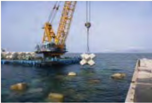
ブロック据付
