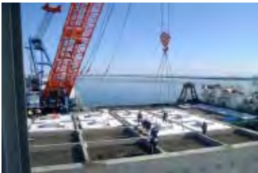
ブロック据付（蓋ブロック）
