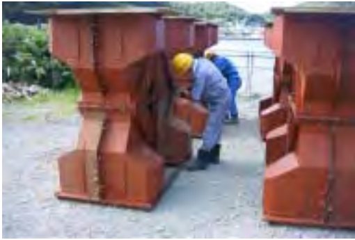
型枠（被覆ブロック）
