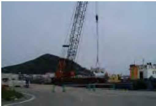
被覆ブロック積込
