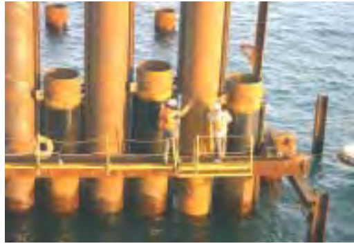
鋼管矢板打設
