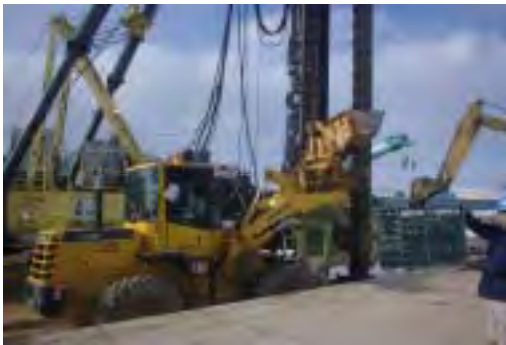
碎石投入（グラベルドレン）
