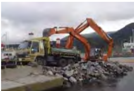
コンクリート取壊し
