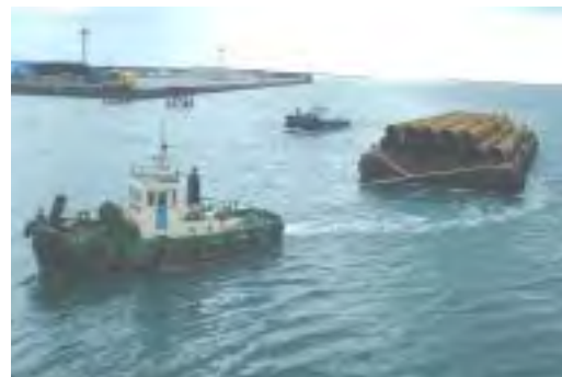
鋼管矢板運搬
