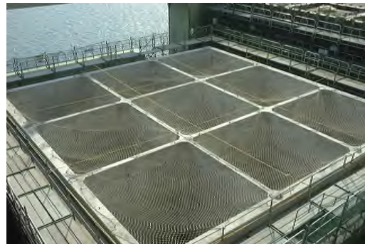
ケーソン完成
