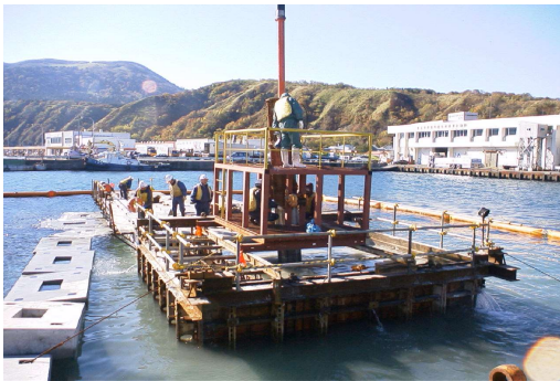
水中コンクリート打設（ケーシング）
