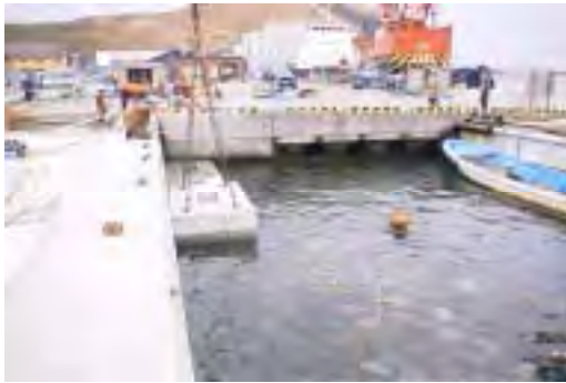
根固ブロック据付（根固方塊）
