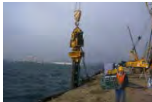
鋼管杭打設
