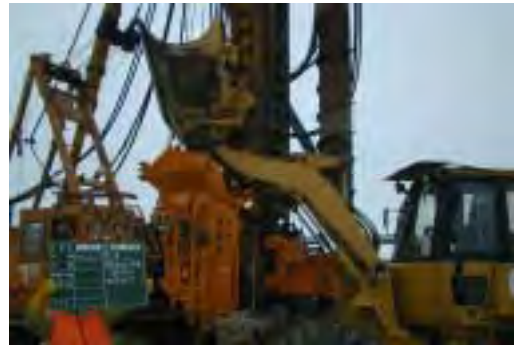
碎石投入（グラベルドレン）
