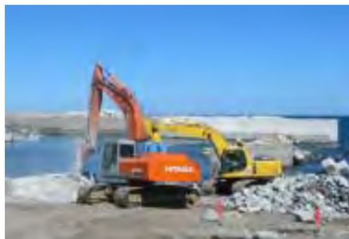
コンクリート取壊し
