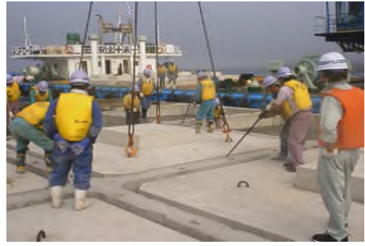
蓋ブロック据付
