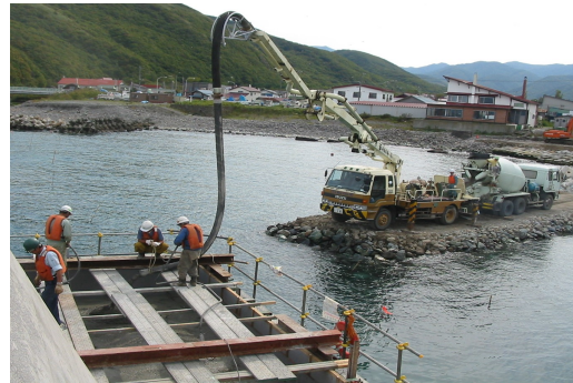
水中コンクリート打設（ポンプ車）
