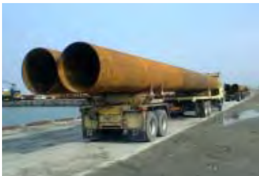
鋼管矢板搬入
