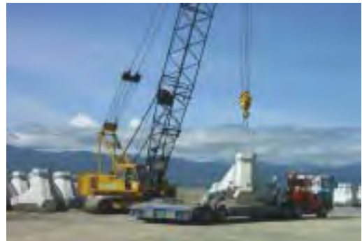
ブロック運搬（トレーラによる）
