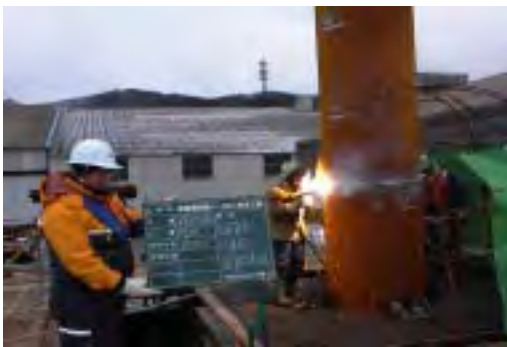
鋼管矢板現場溶接
