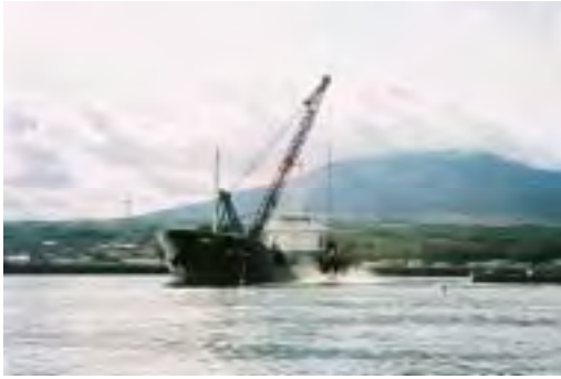
基礎捨石投入
