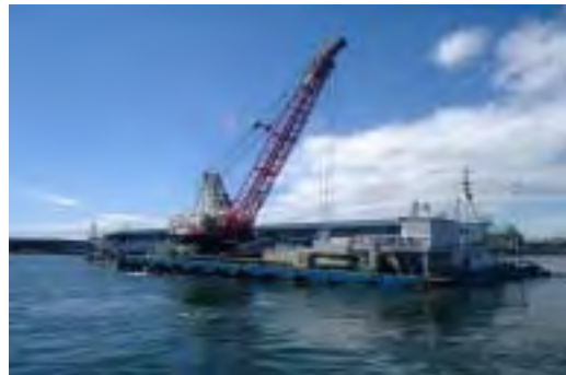
海上運搬（蓋ブロック）
