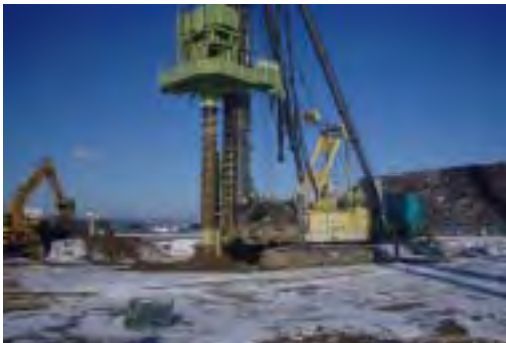
碎石杭打込（グラベルドレン）
