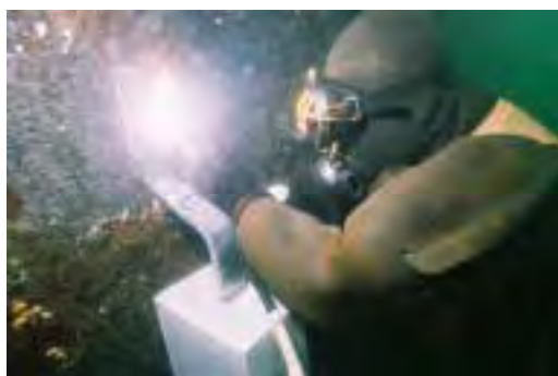
電気防食（陽極取付）
