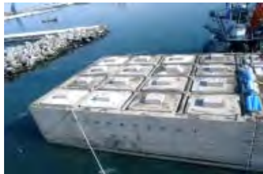
ブロック据付
