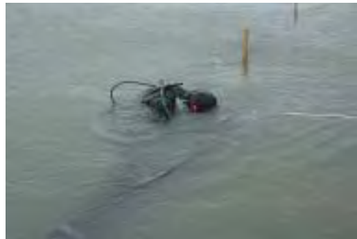
防砂シート敷設
