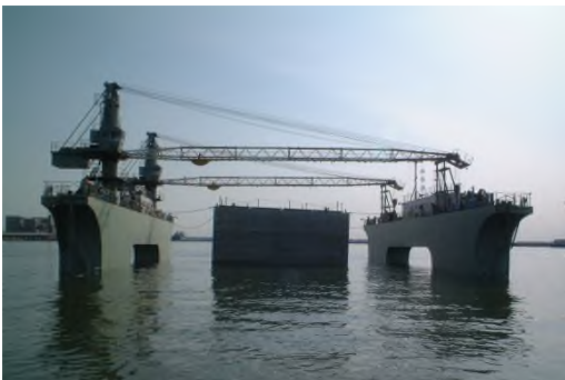
ケーソン進水
