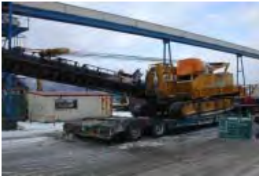
機材搬入（グラベルドレン施工機）
