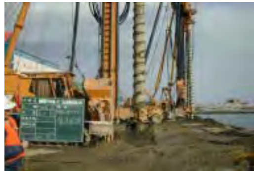
碎石杭打込（グラベルドレン）
