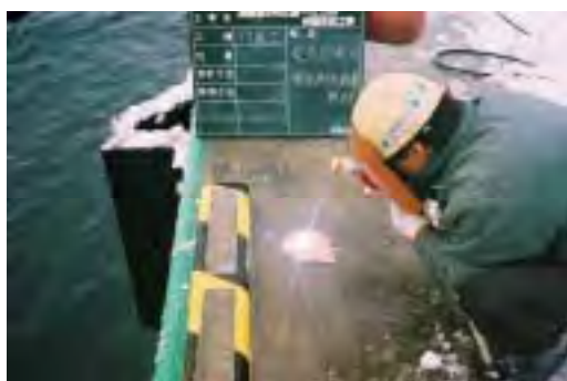
電位測定装置取付
