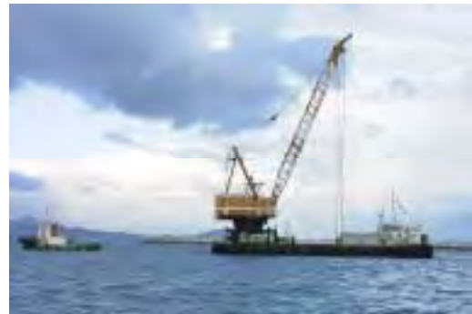
ブロック運搬（起重機船による）
