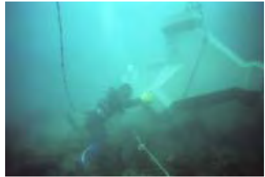
ブロック据付（水中）
