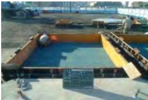
ルーフィング敷設 (蓋ブロック)
