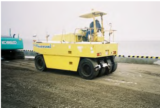
路盤工（上層路盤敷き均し）
