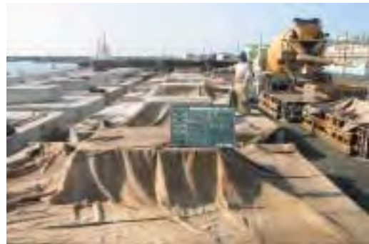
養生（蓋ブロック）
