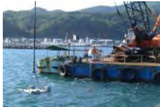
被覆ブロック据付
