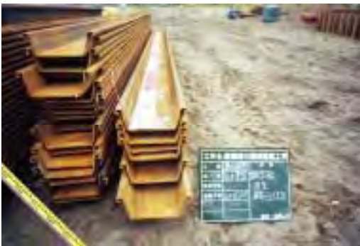
鋼矢板荷卸し
