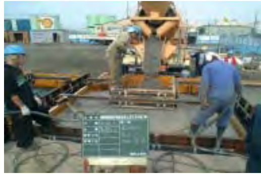
コンクリート打設（蓋ブロック）
