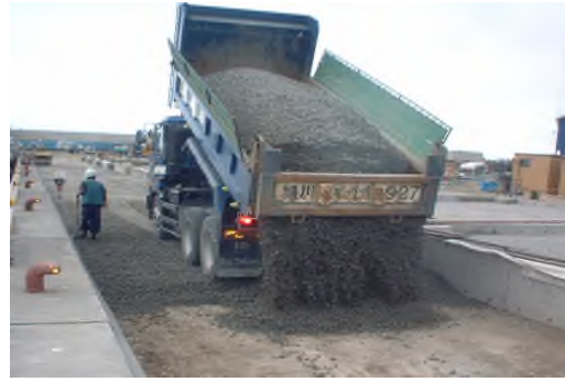
路盤工（下層路盤材投入）
