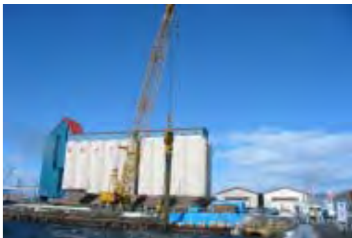
鋼管杭打設
