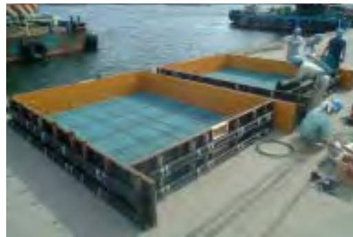
型 枠 (蓋ブロック)
