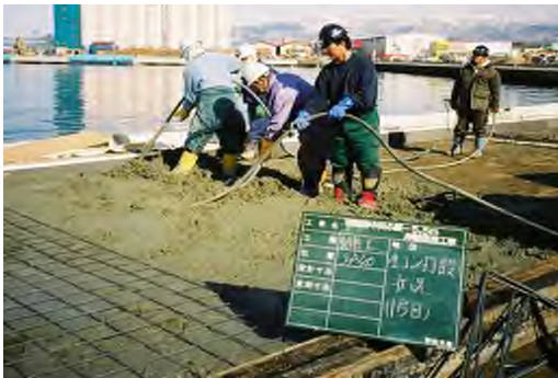
コンクリート舗装（人力舗設）
