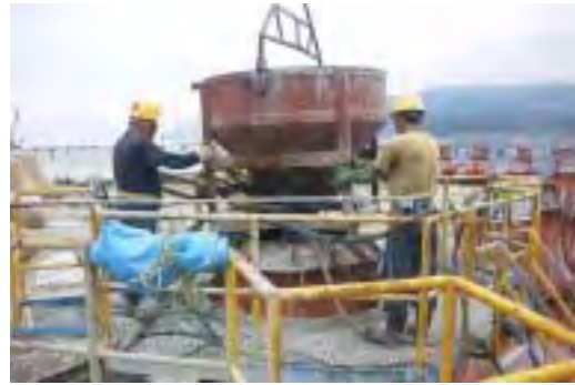
コンクリート打設
