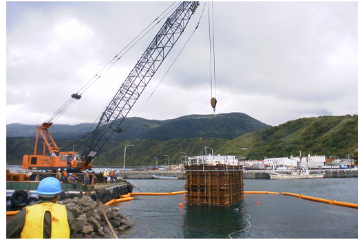
型枠設置(海上施工)
