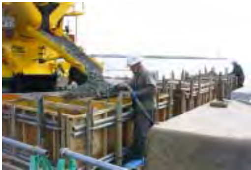
コンクリート打設（根固方塊）
