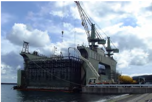
コンクリート打設
