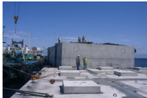
ケーソン据付
