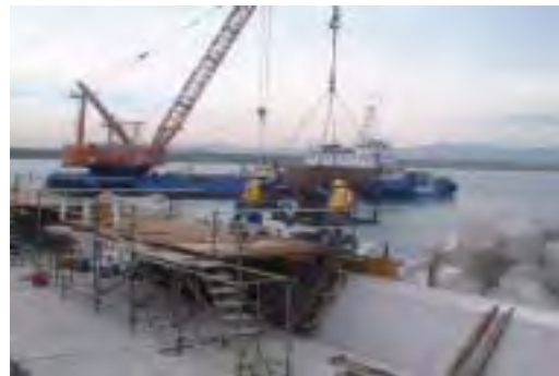
コンクリート打設（重力式）
