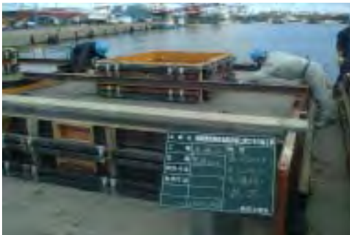
天端均し（蓋ブロック）
