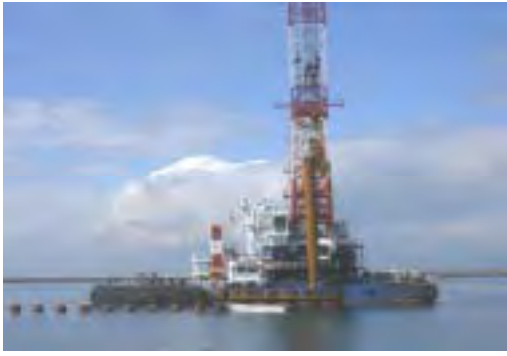
鋼管矢板立て込み
