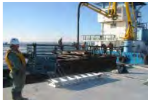
コンクリート打設（ミキサー船による）
