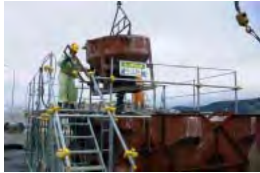
コンクリート打設（被覆ブロック）
