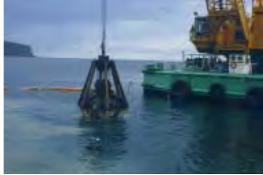
基礎捨石投入
