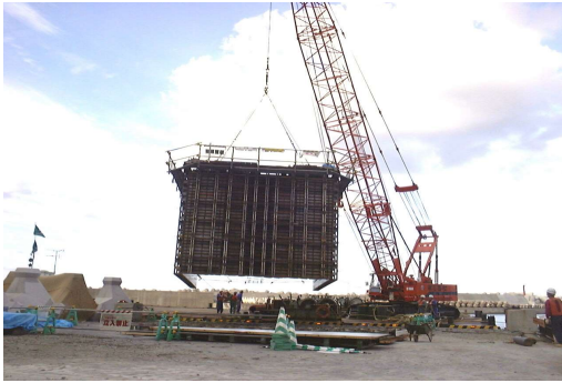
型枠（鋼製型枠組立・組外し）
