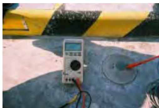
電位測定装置取付
