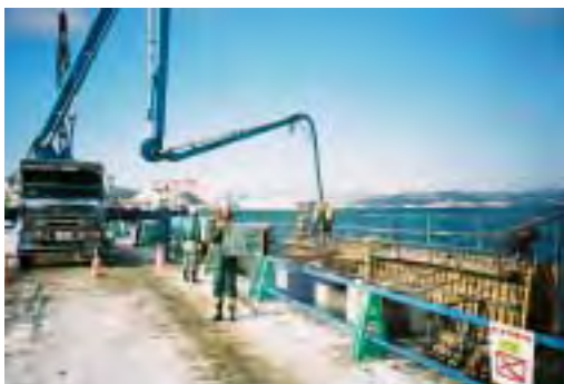
コンクリート打設（矢板式）
