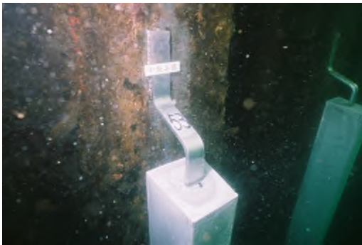
電気防食 (陽極・取付金具)
