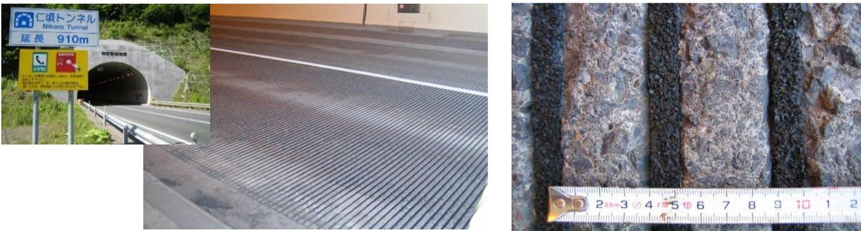
仁頃トンネルでの凍結抑制舗装（コンクリートグルーピング+ゴムチップ）
