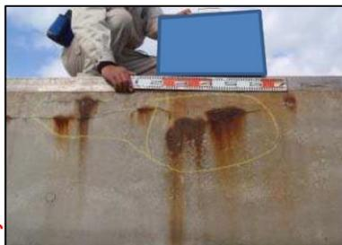
鉄筋の腐食に伴い発生する錆汁
