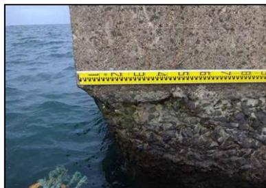
無筋コンクリート構造物の干満帯における、凍結融解による損耗劣化
