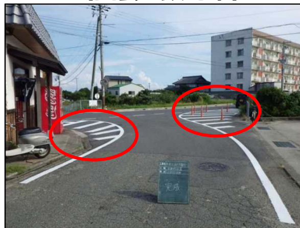
交差点部の狭さくによる速度抑制 (出会い頭対策)
