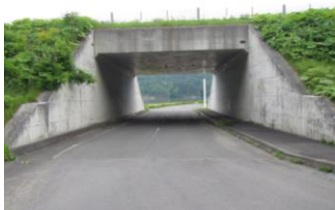
一般国道38号 滝里函渠（芦別市）
