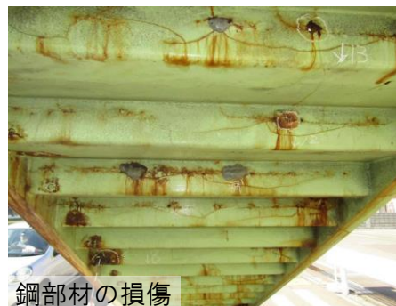
門型標識等 (オーバーヘッド形式の道路標識、情報提供装置等)
