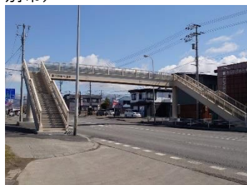
一般国道227号 七重浜横断歩道橋（北斗市）
