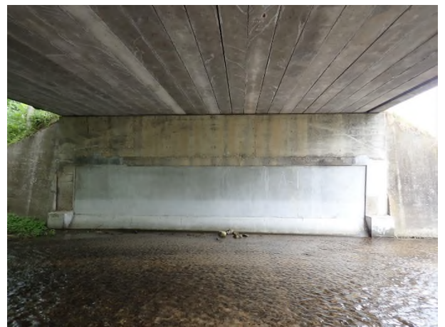
橋台コンクリート 打ち替えによる対策を実施
