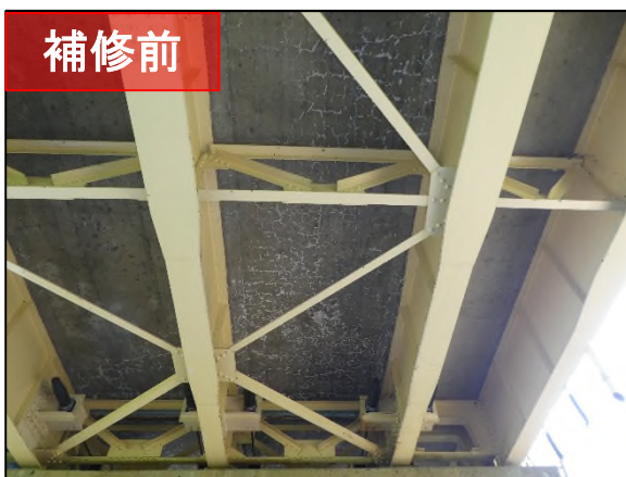
床版下面の損傷(ひびわれ、漏水)
