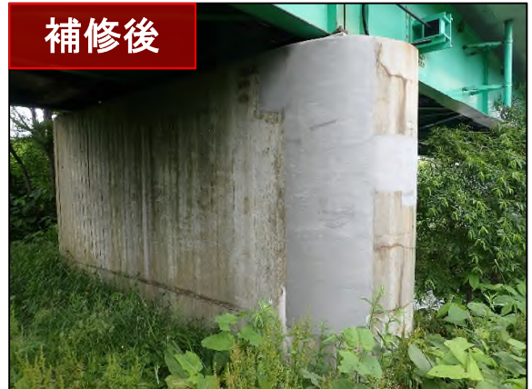
橋脚の補修(断面修復)
