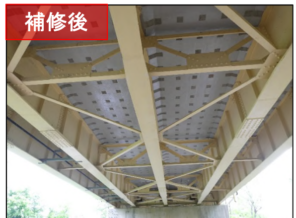
床版下面の補修(炭素繊維接着補強)
