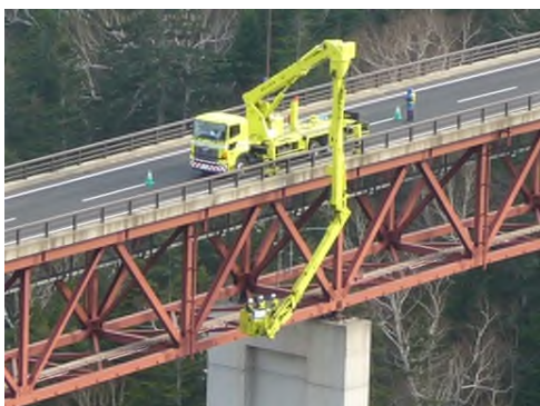
橋梁点検車による定期点検
