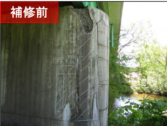
橋脚の損傷(剥離・鉄筋露出、うき)
