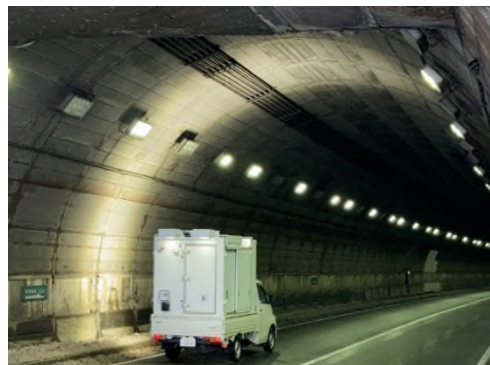
画像計測技術による覆工撮影
