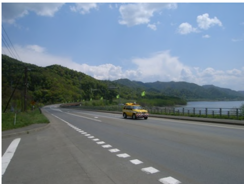
パトロール車による道路巡回
