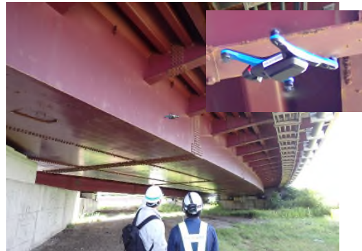
新技術による定期点検
