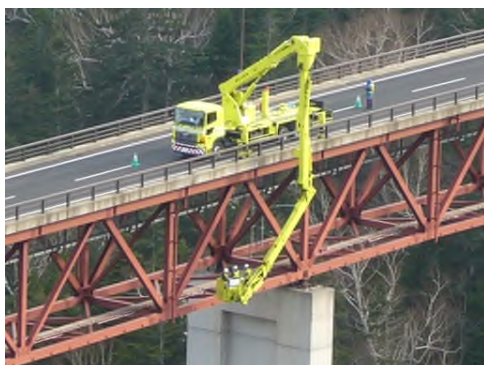
橋梁点検車による定期点検
