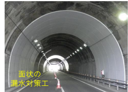
写真一面状の漏水対策工（防水パネル工） ※断熱材付き面型パネルによる漏水対策
