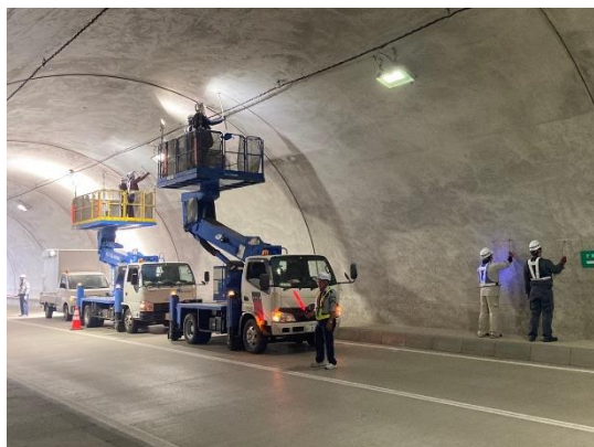
一般国道229号 新美谷トンネル（せたな町）
