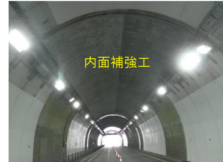
写真一内面補強工（格子筋補強工） ※ポリマーセメントモルタル+格子鉄筋による増厚補強
