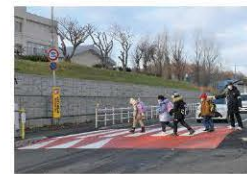
▲可搬型ハンプを用いたスムーズ横断歩道の整備(留萌市)
