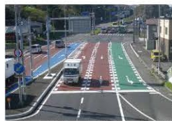
▲カラー舗装による車線の明確化 (国道36号 登別市)
