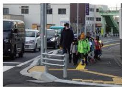
▲防護柵の整備による子供の安全な通行の確保 (国道36号 千歳市)
