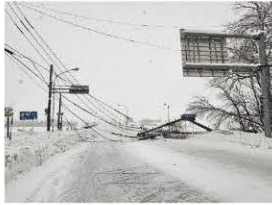
▲暴風雪による電柱倒壊 (R4.12.23 国道38号 幕別町)
