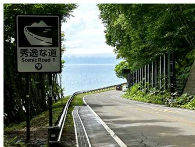
No.1 支笏湖ブルーに出逢う道 (8/9に設置)
