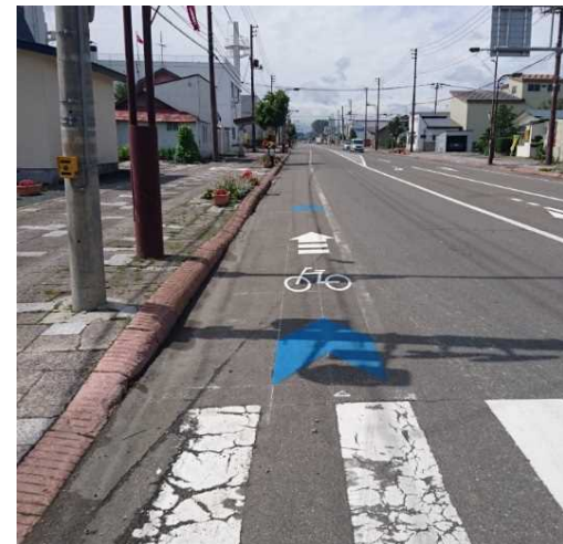
■路面表示の試行状況「交差点」 (トカプチ400 中札内村 国道236号)
