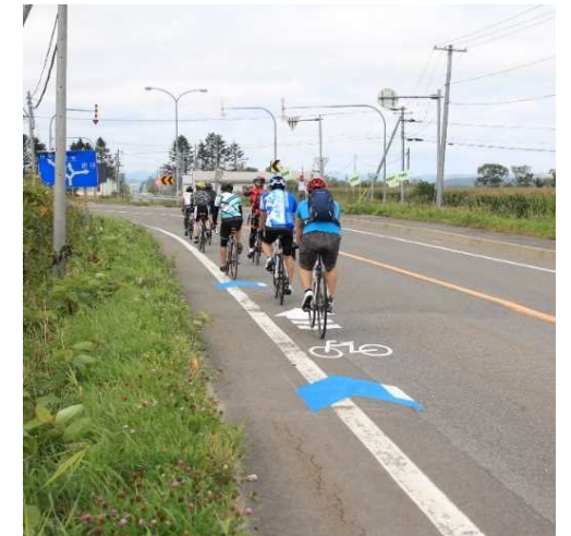
■路面表示の試行状況「急カーブの手前」 (トカプチ400 浦幌町 国道336号)
