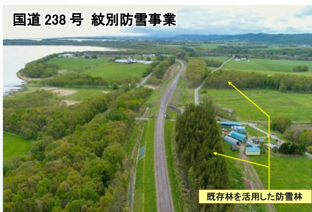
図4 既存林を活用した防雪対策
