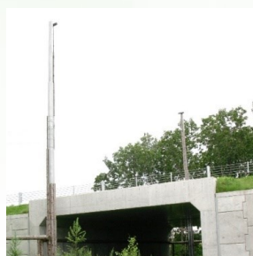
◆エゾモモンガの移動経路確保 ◆滑空用柱で森林分断を解消
