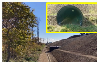
◆キツネの移動経路確保 ◆小動物横断用管渠で生息域分断を解消
