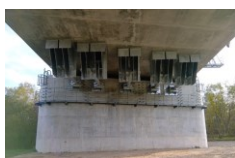
橋梁の耐震補強対策 落橋防止装置設置 （国道236号 土狩大橋（芽室町））
