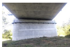
橋梁の耐震補強対策 落橋防止装置設置 （国道236号 土狩大橋（芽室町））
