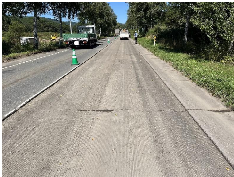
切削面の ひび割れ
