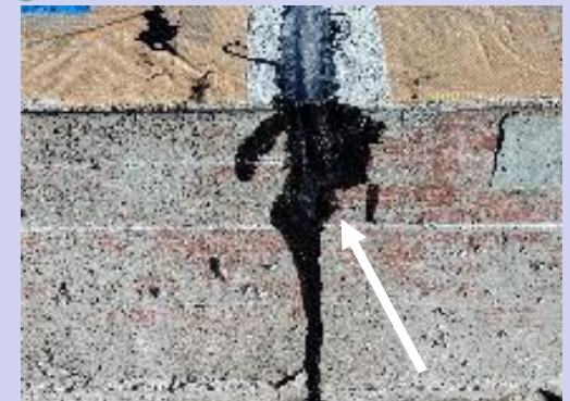
注入後の目視調査
