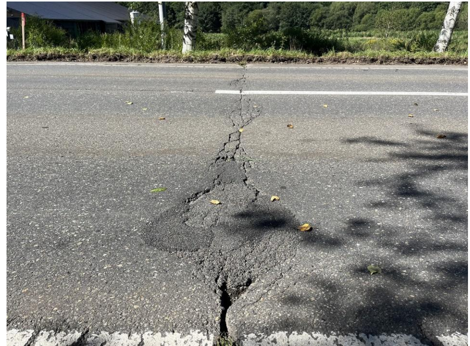
輪跡部が亀甲状ひび割れとなり、 ポットホールに進行 →パッチングで補修
