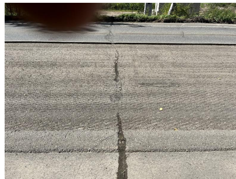
切削面の ひび割れ
