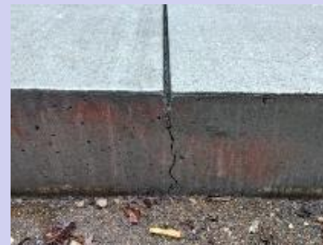
注入前の目視調査
