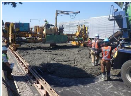
1層打設での施工
