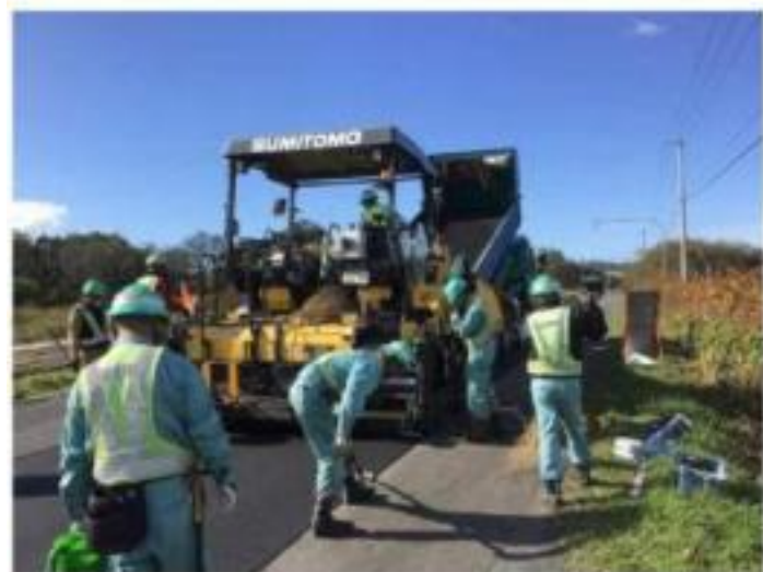
敷均し アスファルトフィニッシャ 敷均し温度 136℃
