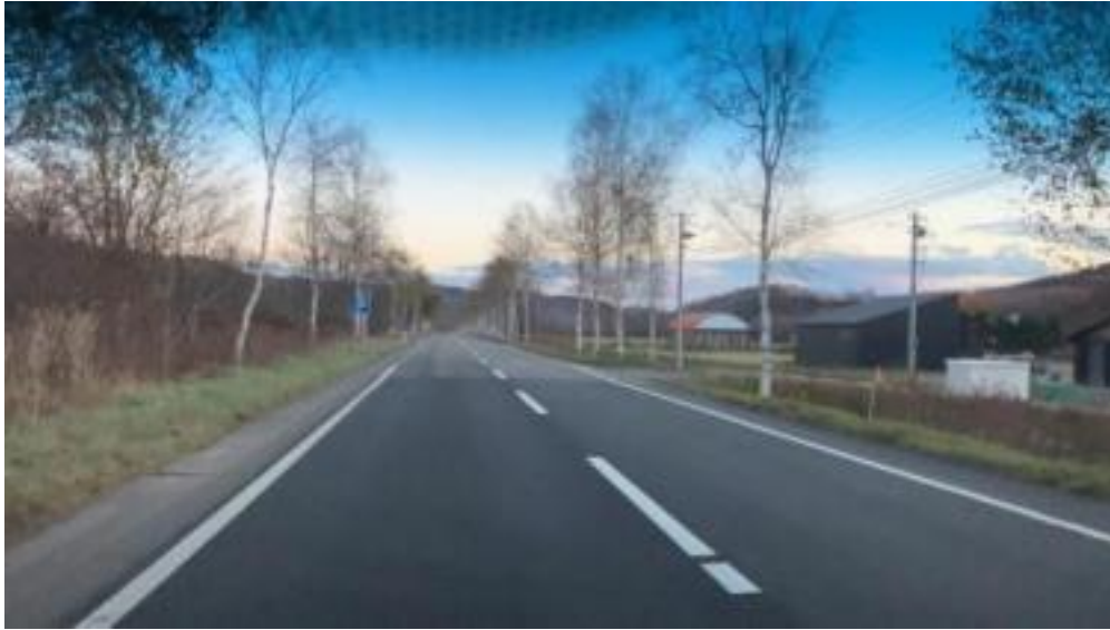
施工起点から10m付近
