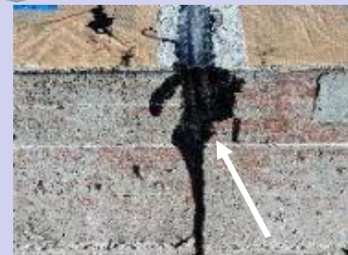
注入後の目視調査
