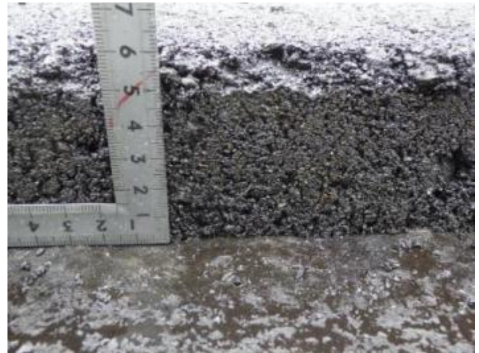
コテ作業あり
