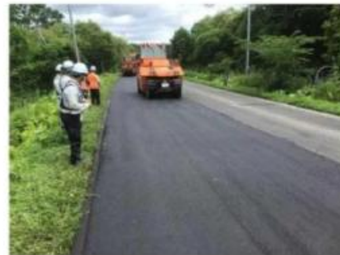
二次転圧 タイヤローラ 締固め目標温度 100±10℃
