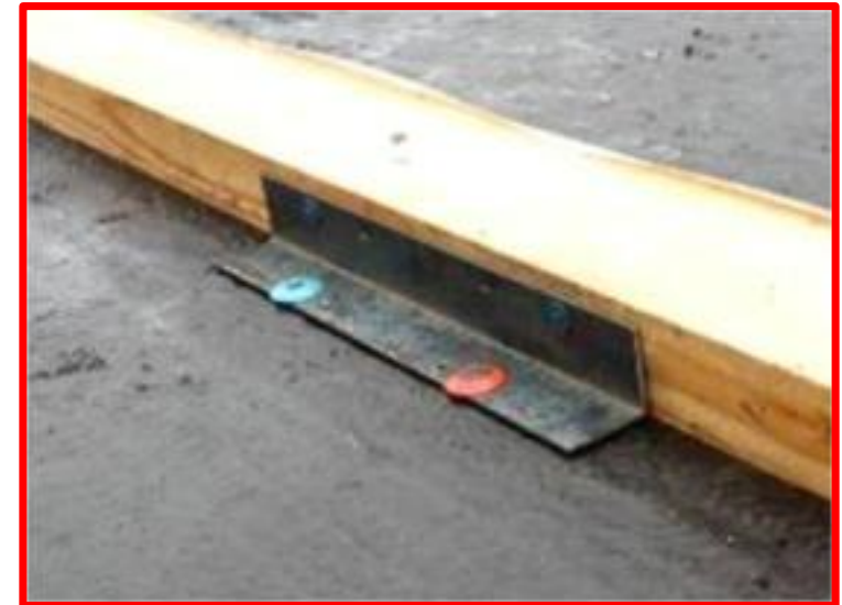
L型アンクルで型枠を固定
