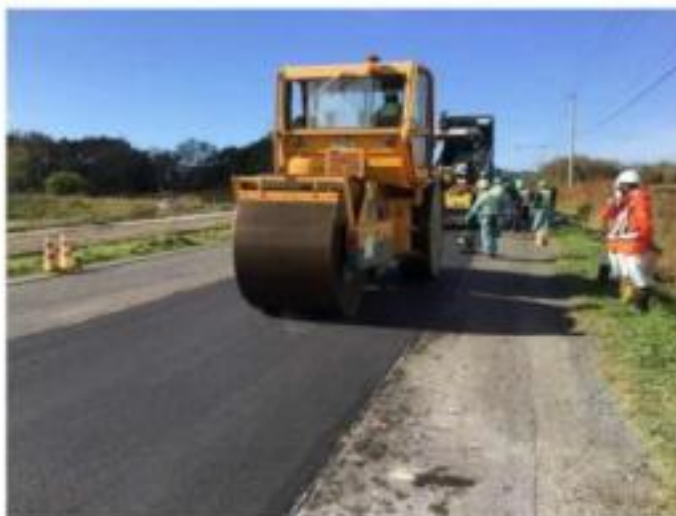
初転圧 マカダムローラ 締固め目標温度 125±10℃
