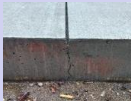
注入前の目視調査
