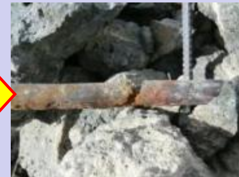
腐食・破断
