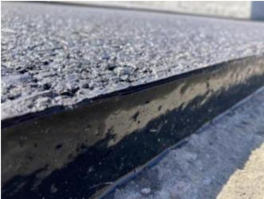
型枠・離型紙撤去後
