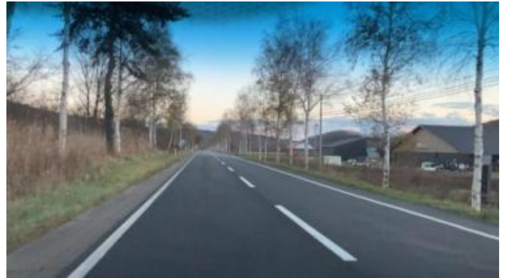
施工起点から80m付近
