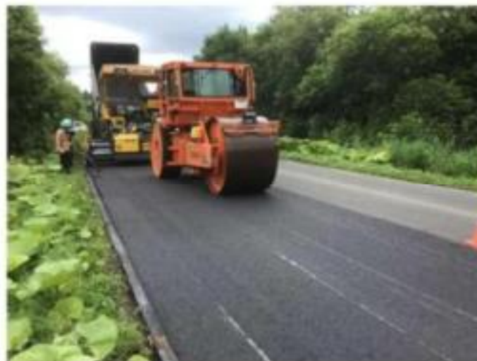
初転圧 マカダムローラ 締固め目標温度 155~165℃
