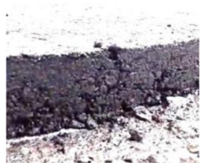
型枠撤去後の表層側面の例
