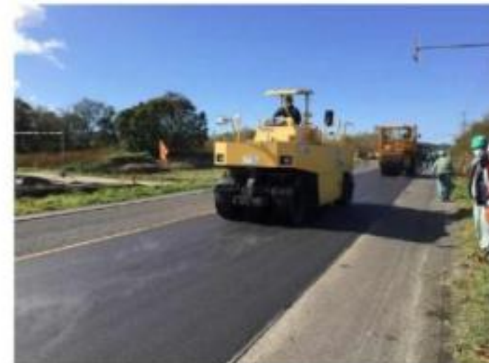
二次転圧 タイヤローラ 締固め目標温度 80±10℃
