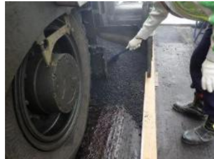
コテによる混合物の供給
