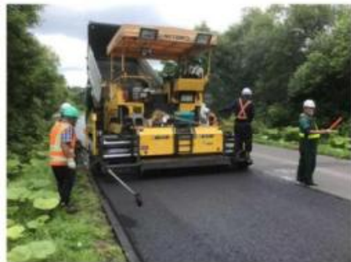
敷均し アスファルトフィニッシャ 敷均し温度 170~175℃
