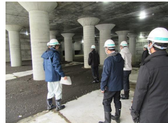
現地見学②(望月寒川放水路) 取水口越流部(地下)
