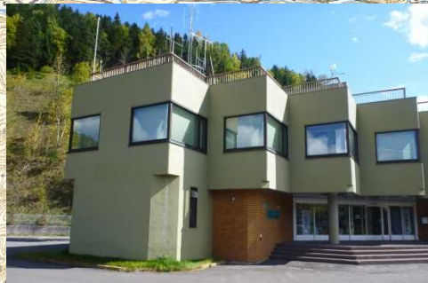
ダム管理支所
