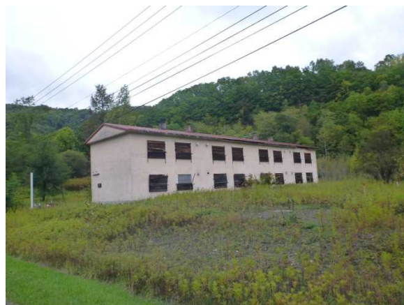
ダム下流の廃屋
