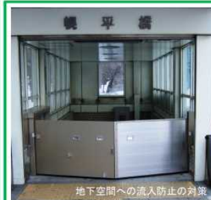
地下空間への流入防止の対策 (札幌市ほか)
