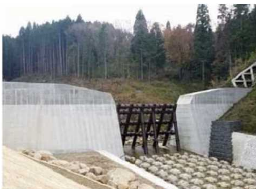
砂防関係施設整備
