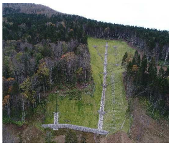
【上川南部署南富良野町】
