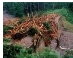
流木捕捉式治山ダム
