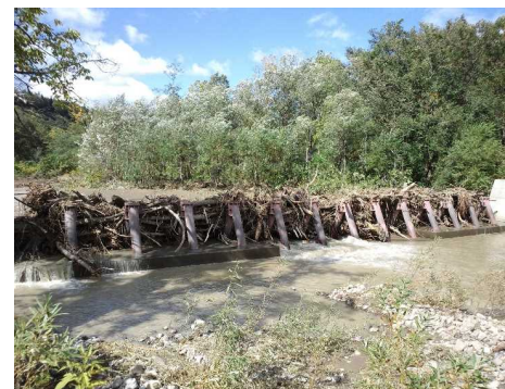
流木捕捉式治山ダムが流木を捕捉した事例【北空知支署朱鞠内】
