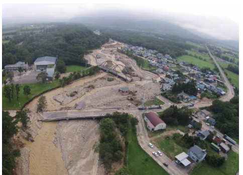
十勝川水系ペケレベツ川における浸水被害
