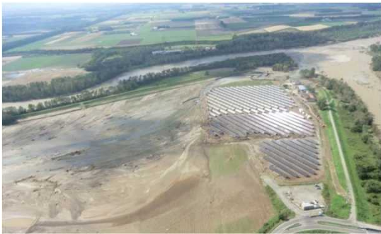
十勝川水系札内川の氾濫状況(帯広市)
