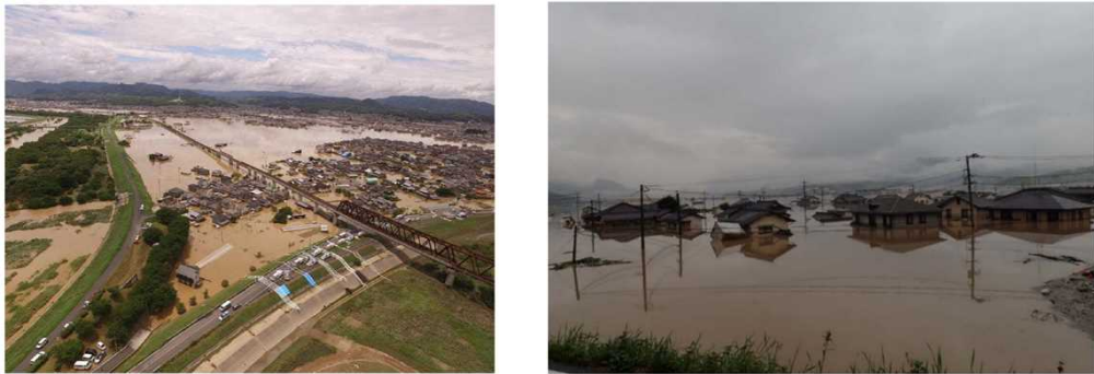
岡山県倉敷市における浸水被害 ※2※3
