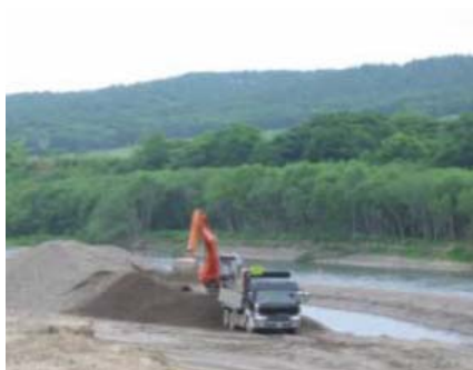
河道掘削した土砂を、
