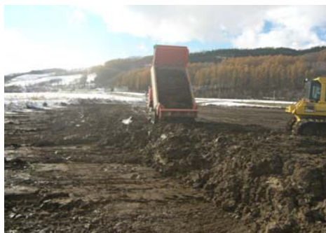
土砂が流出した農地へ運搬し、
