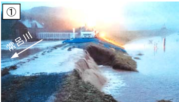
① KP22.6左岸の堤防越水状況
