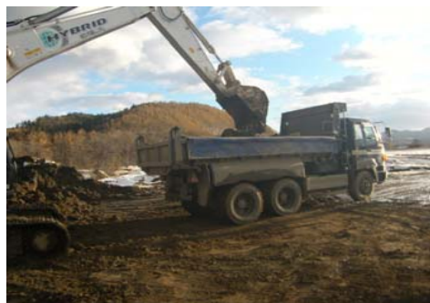
ダンプトラックへ積み込み、
