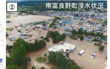
② 南富良野町浸水状況
