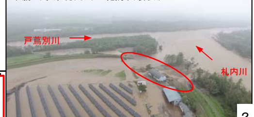
十勝川水系札内川の堤防決壊状況
