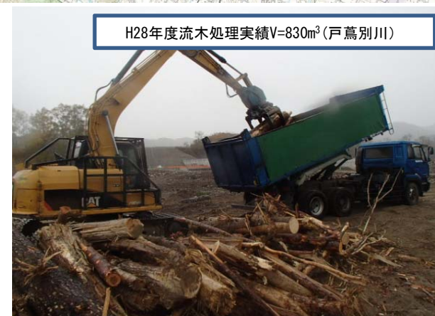
戸蔭別川流木除去状況
