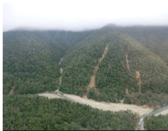
戸蔭別川第5号砂防堰堤
