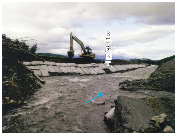
ペンケオタソイ川溪岸流出箇所のブロック設置
