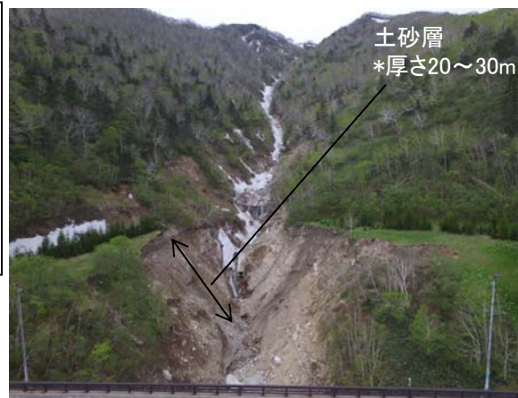
▲ペケレベツ川源頭部付近の崩壊
