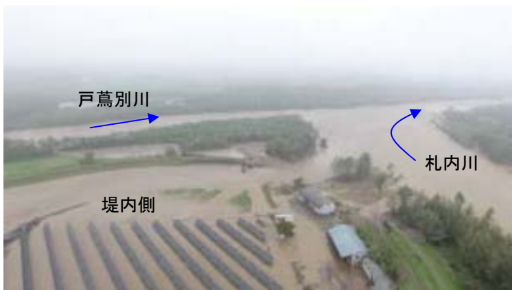
台風第10号による堤防決壊 (浸水面積 約50ha, 浸水家屋2戸等)
