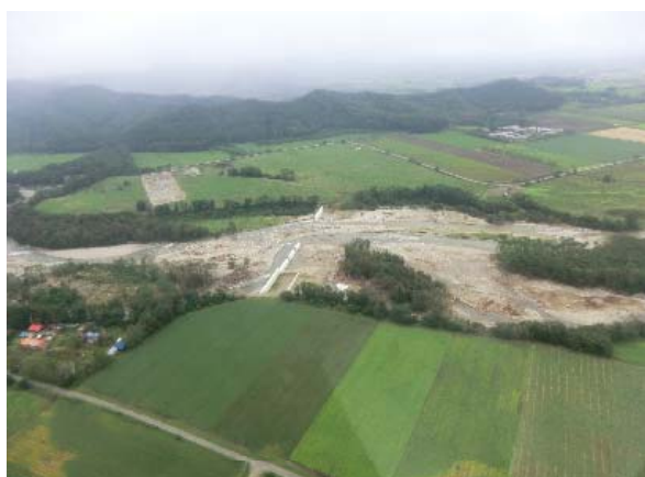
戸蔭別川第2号砂防堰堤
