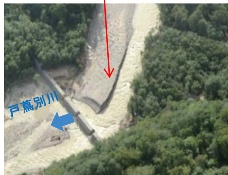
戸蔭別川第5号砂防堰堤
