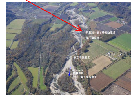
出水後 (平成28年撮影)
