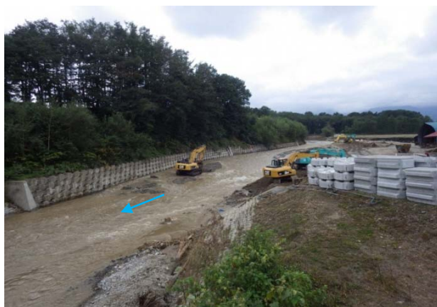
芽室川護岸流出箇所の築堤及びブロック設置
