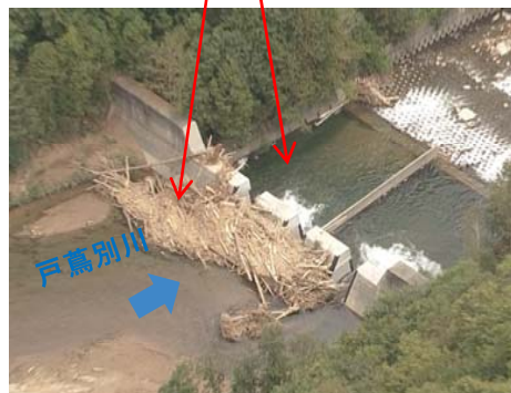
戸蔭別川第7号砂防堰堤
