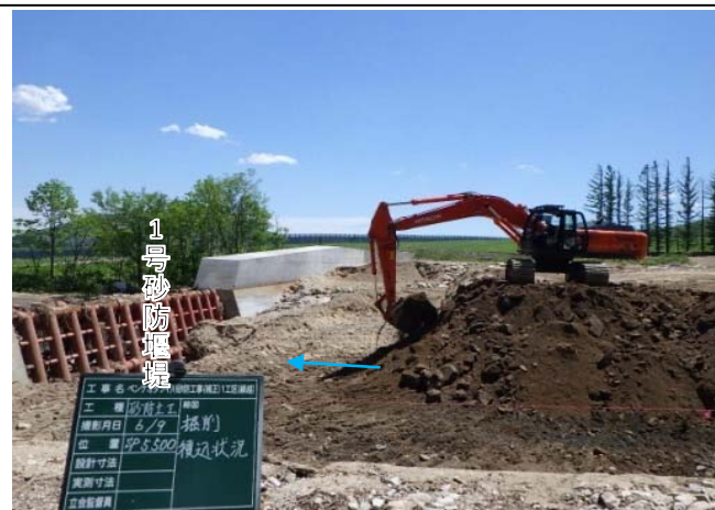
ペンケオタソイ川1号砂防堰堤捕捉土砂の除石
