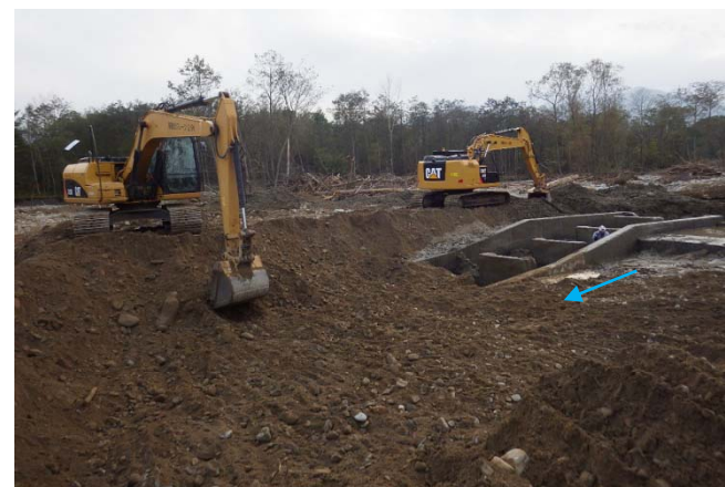
芽室川溪流保全工区間河道埋塞除去
