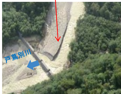
戸蔭別川第5号砂防堰堤
