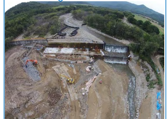
芽室川4号砂防堰堤工 施工中 17
