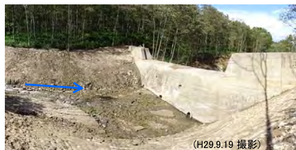
ペンケオタソイ川 2号砂防堰堤 撤去後
