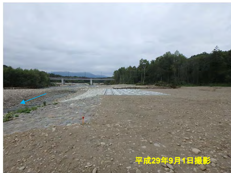
戸蔭別川第7号床固工(左岸側壁護岸流出):復旧完了
