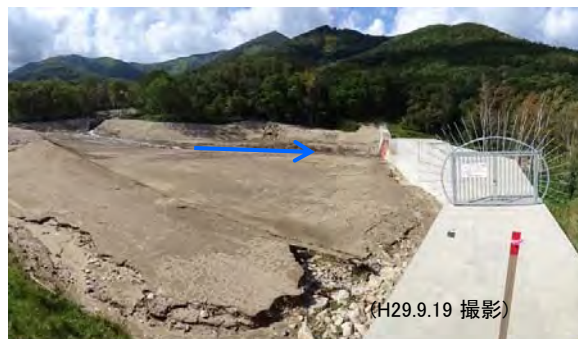
ペンケオタソイ川1号砂防堰堤 撤去後
