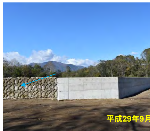
戸蔭別川第4号床固工 (左岸導流堤・護床工流出・副堤天端欠損):復旧完了
