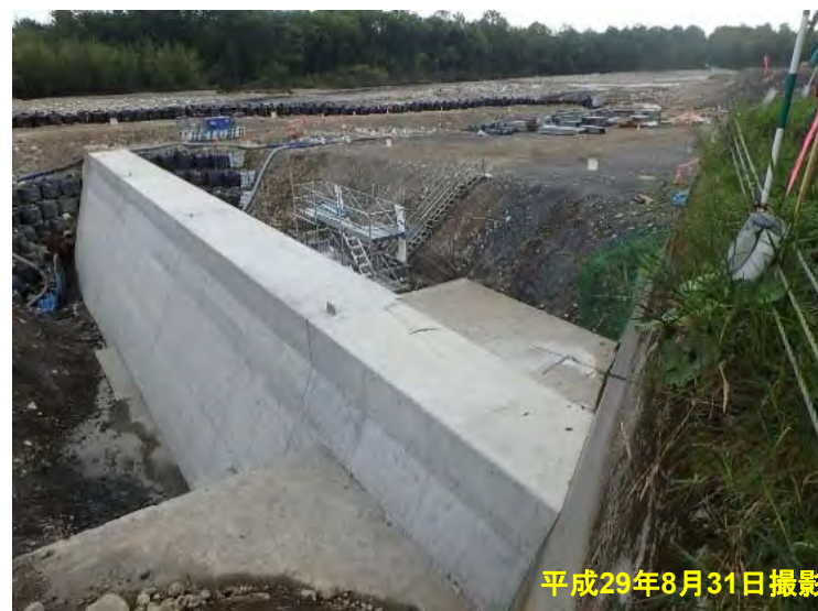
戸蔭別川第11号床固工(右岸本堤・側壁護岸流出):復旧完了
