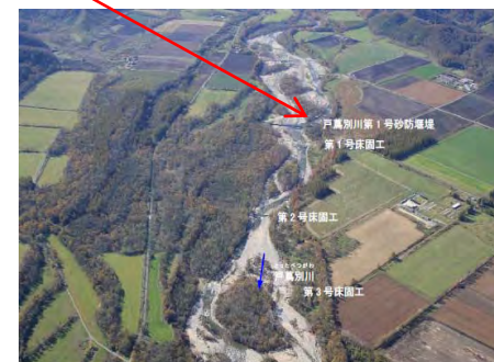
出水後 (平成28年撮影)
