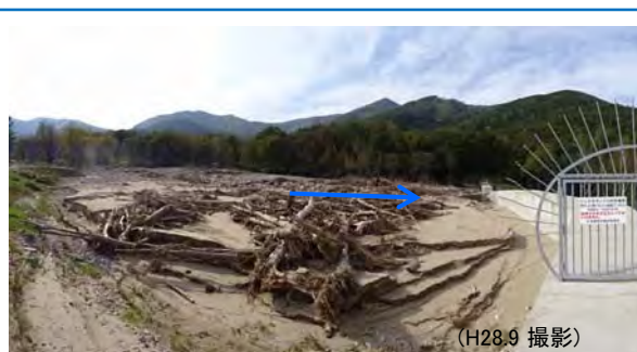
ペンケオタソイ川1号砂防堰堤 被災直後
