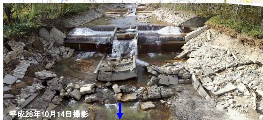
ペケレベツ川渓流保全工最下流の13号落差工(垂直壁・魚道倒壊, 護床工・護岸工流出): 施工中
