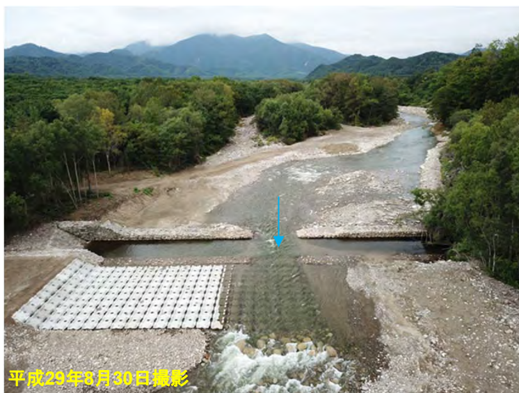
戸蔭別川第2号床固工(護床工流出):復旧完了
