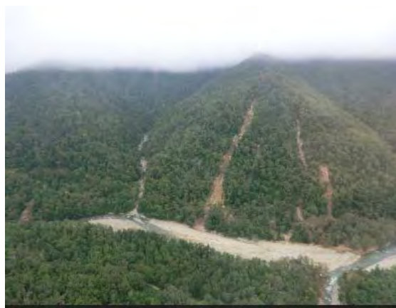
戸蔭別川第5号砂防堰堤
