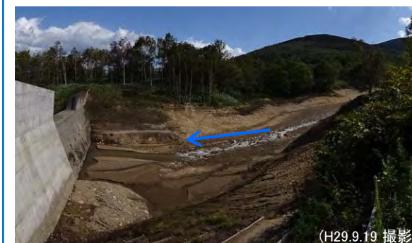
ペンケオタソイ川 3号砂防堰堤 撤去後
