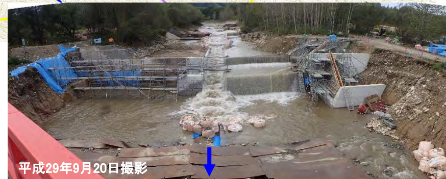
ペケレベツ川渓流保全工最下流の13号落差工(垂直壁・魚道倒壊, 護床工・護岸工流出): 施工中
