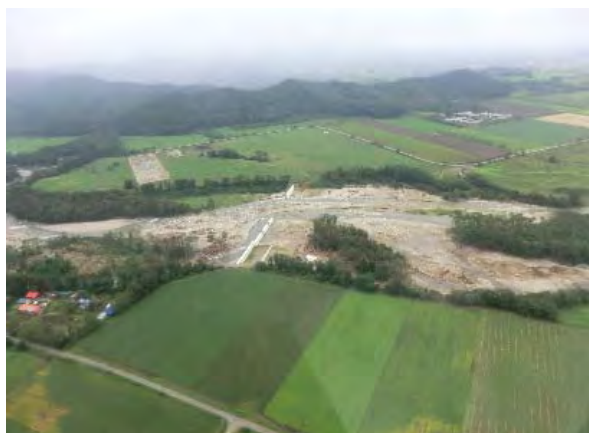
戸蔭別川第2号砂防堰堤
