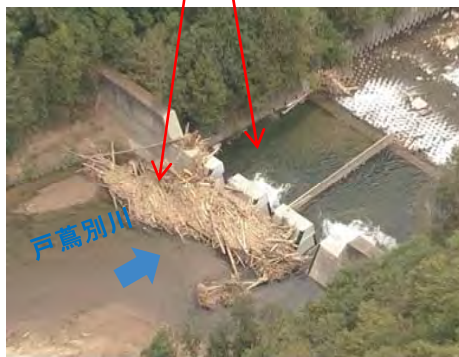
戸蔭別川第7号砂防堰堤
