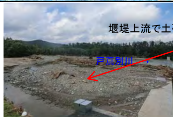
戸蔭別川第1号砂防堰堤の効果(平成28年撮影)
