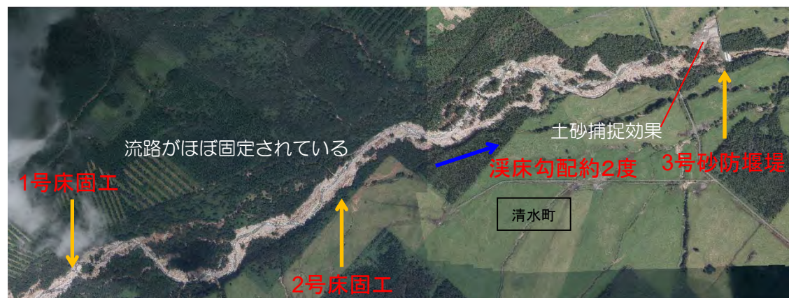
芽室川被災後の3号砂防堰堤から上流付近の扇状地区間の状況 (流域面積 31\text{km}^2 ，元溪床勾配約 2^{\circ} )
