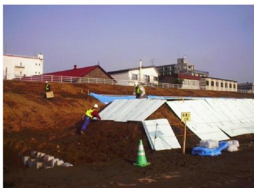
【仮置き土の養生（シート+板状断熱材）】
