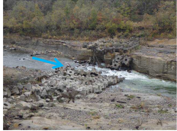
図 1.8 帯工の被災
