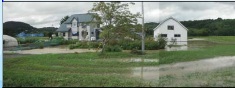
むかわ 鶴川水系穂別川(被害状況)H28.8.25撮影
