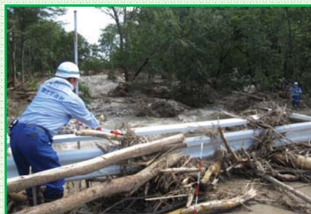
小林川 流木堆積 (清水町)
