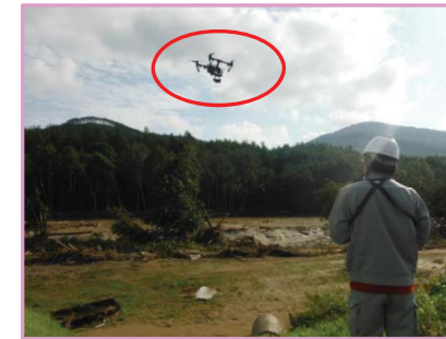
ドローンによる被災状況 確認(南富良野町)
