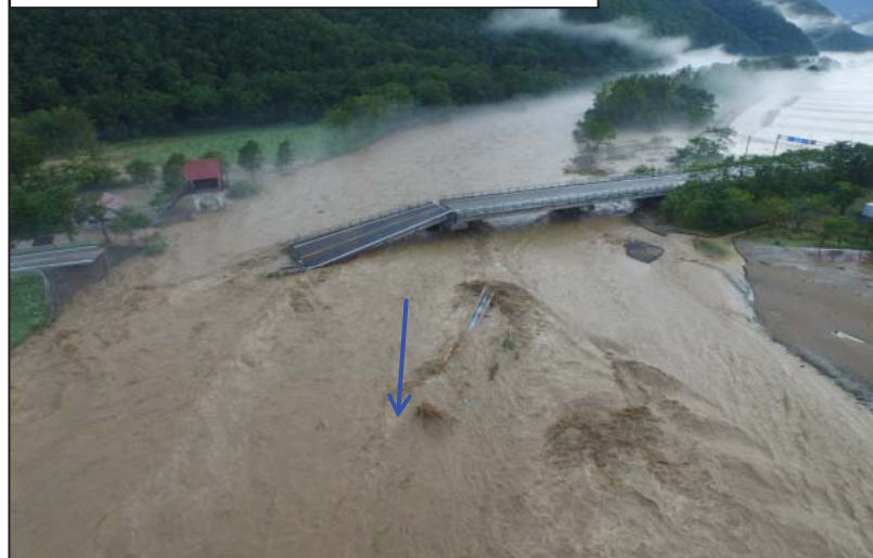
国道38号 太平橋の被害状況
