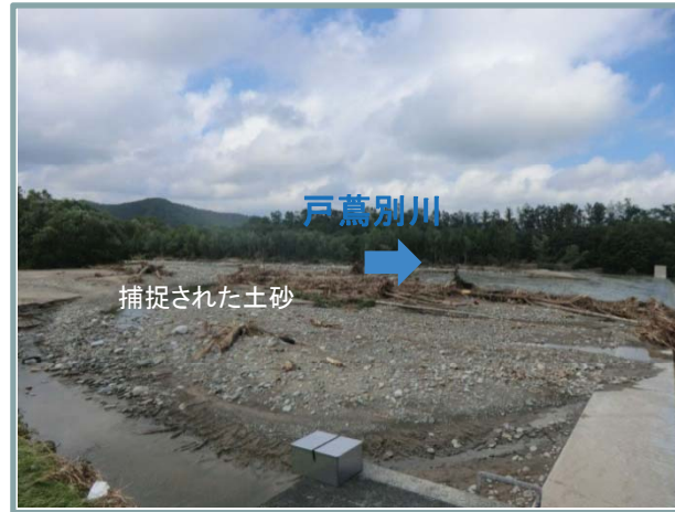
砂防施設による土砂の捕捉効果(平成28年9月2日)
