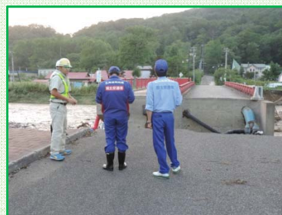
神社橋 橋台背面洗掘 (新得町)
