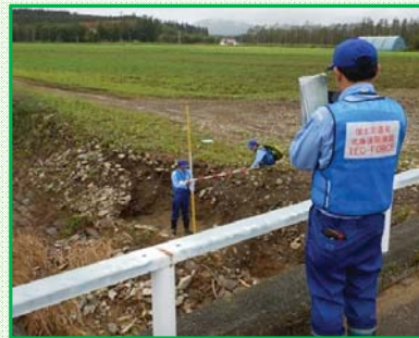
サラベツ川 河岸洗掘 (中札内村)
