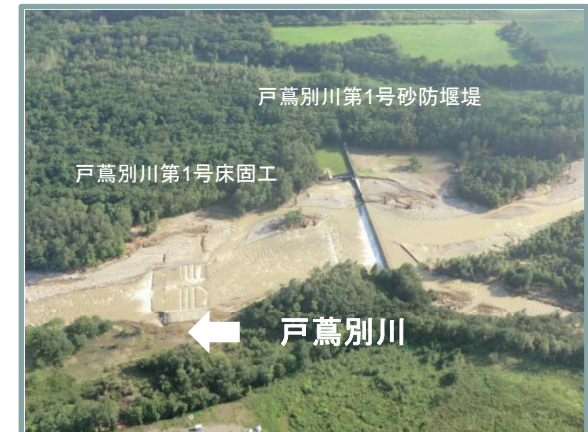
砂防施設による土砂の捕捉効果(平成28年9月1日) 29
