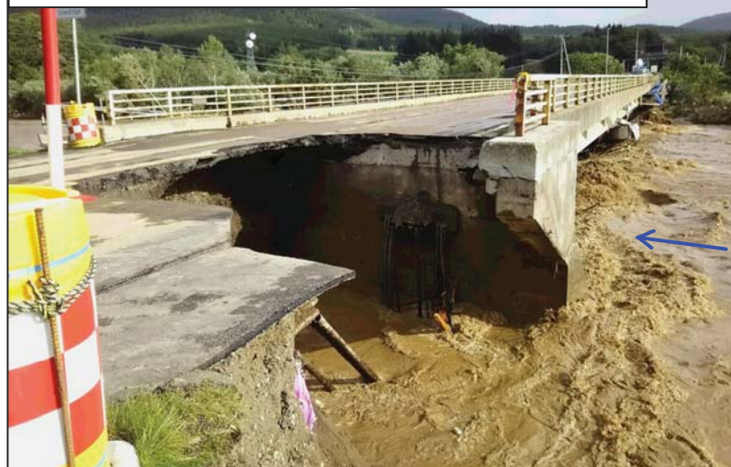
国道38号 太平橋の被害状況
