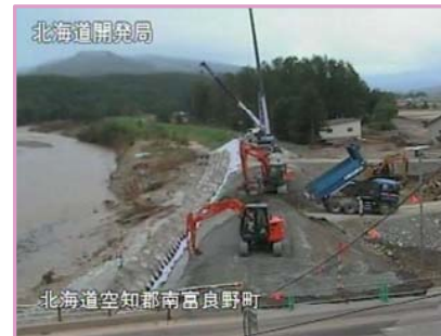
空知川堤防決壊箇所への復旧を監視 (南富良野町)※衛星通信車による画像
