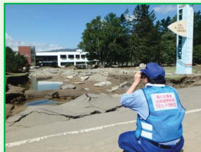
役場敷地内道路の損傷 (南富良野町)
