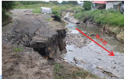
清水町: 排水路の被災 (護岸の流失)
