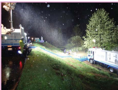
照明車と排水ポンプ車 緊急排水作業(幕別町)
